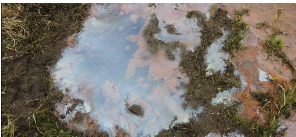
Abb. 11: Extreme Verockerung und Verschlammung mit öligem Film im Graben
