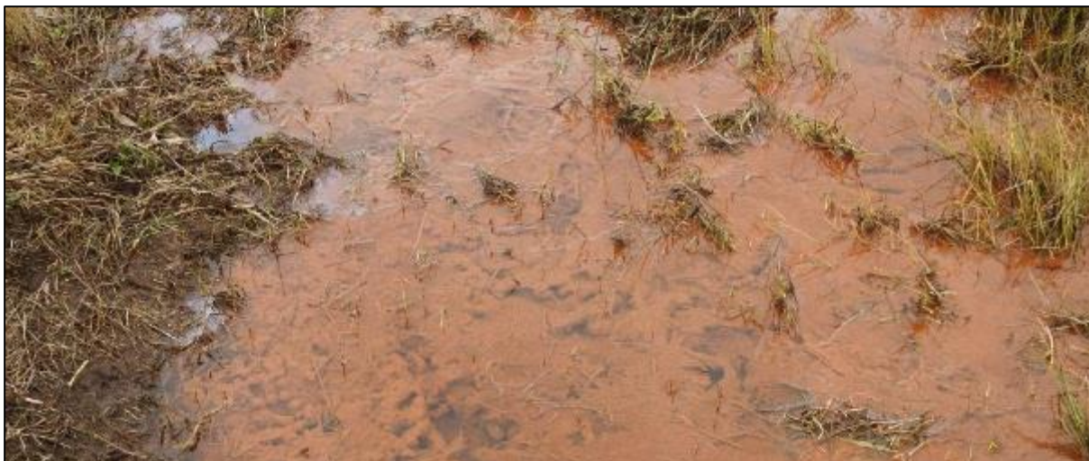
Abb. 11: Extreme Verockerung und Verschlammung mit öligem Film im Graben
