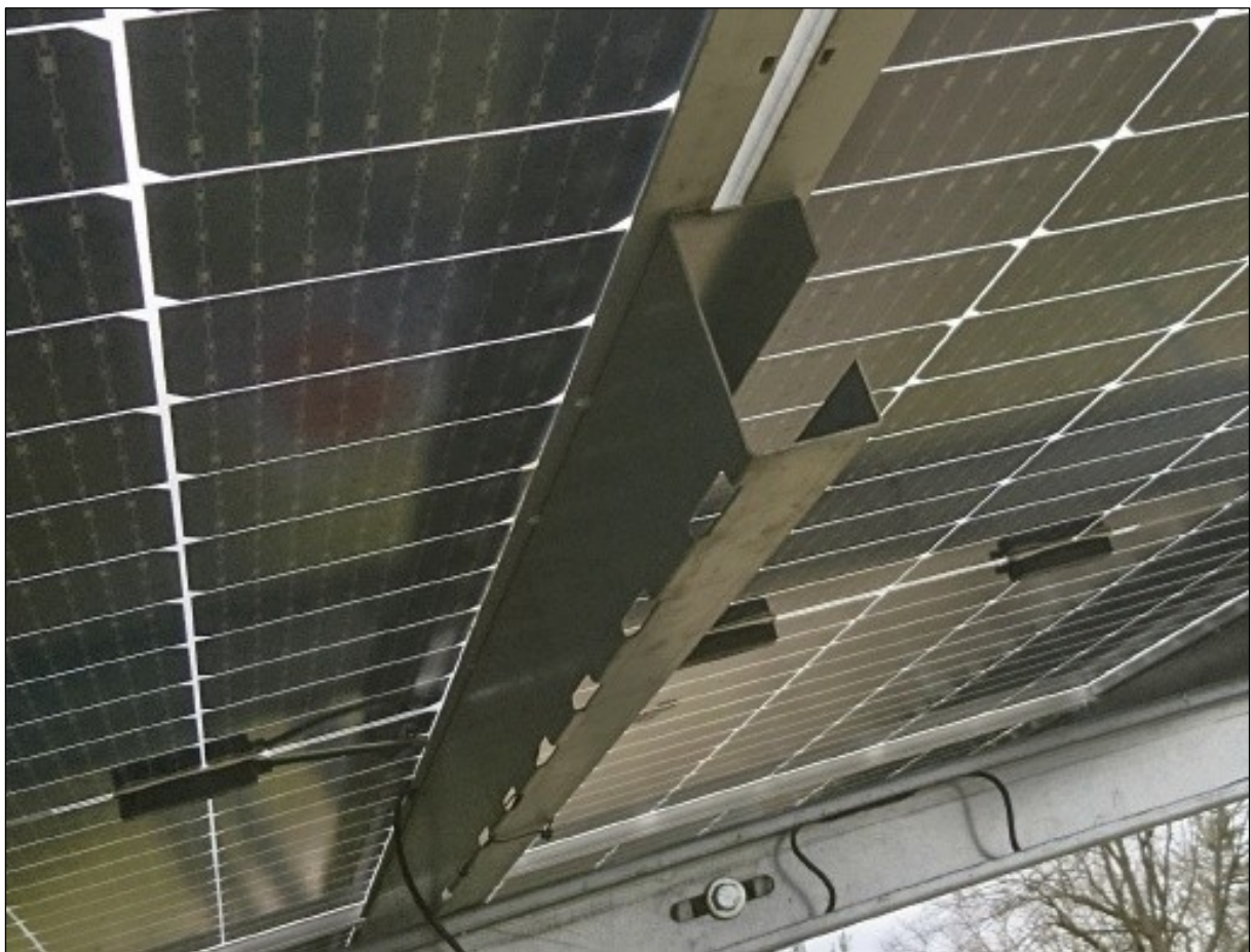
Abb. 2 Regenwasserverteilsystem unter den Modulen (Foto: SUNFARMING)
