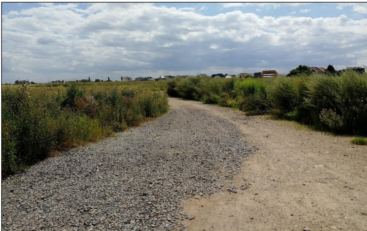
Abb. 3: befestigte Baustraße im Bereich der geplanten Bebauung
