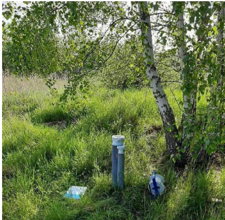
Abbildung 3: vorhandene Grundwassermessstelle (GWM) im zentralen UG, Blickrichtung Nord
