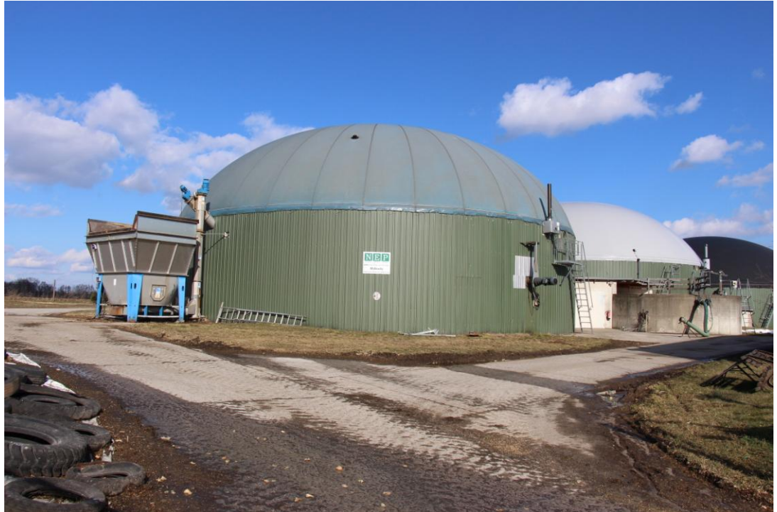
Foto 3: Blick vom Anlagengelände in Richtung Nordosten auf die Behälter der vorhandenen Biogas- und BHKW-Anlage der Agrargut Malkwitz KG am nördlichen Rand des derzeit bestehenden Anlagengeländes.
