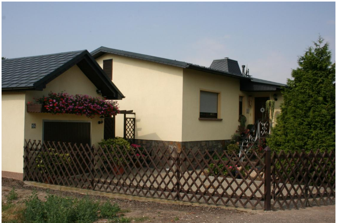
Foto 6: Blick in Richtung Südwesten auf das Wohngebäude IO 1 „Dahlener Straße 32“ (links: Ostfassade, rechts: Nordfassade).
