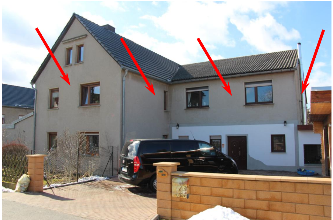
Foto 7: Blick in Richtung Südwesten auf das Wohngebäude IO 2 „Feldstraße 1a“ (von links nach rechts: südliche Ostfassade, östliche Nordfassade, nördliche Ostfassade, westliche Nordfassade).
