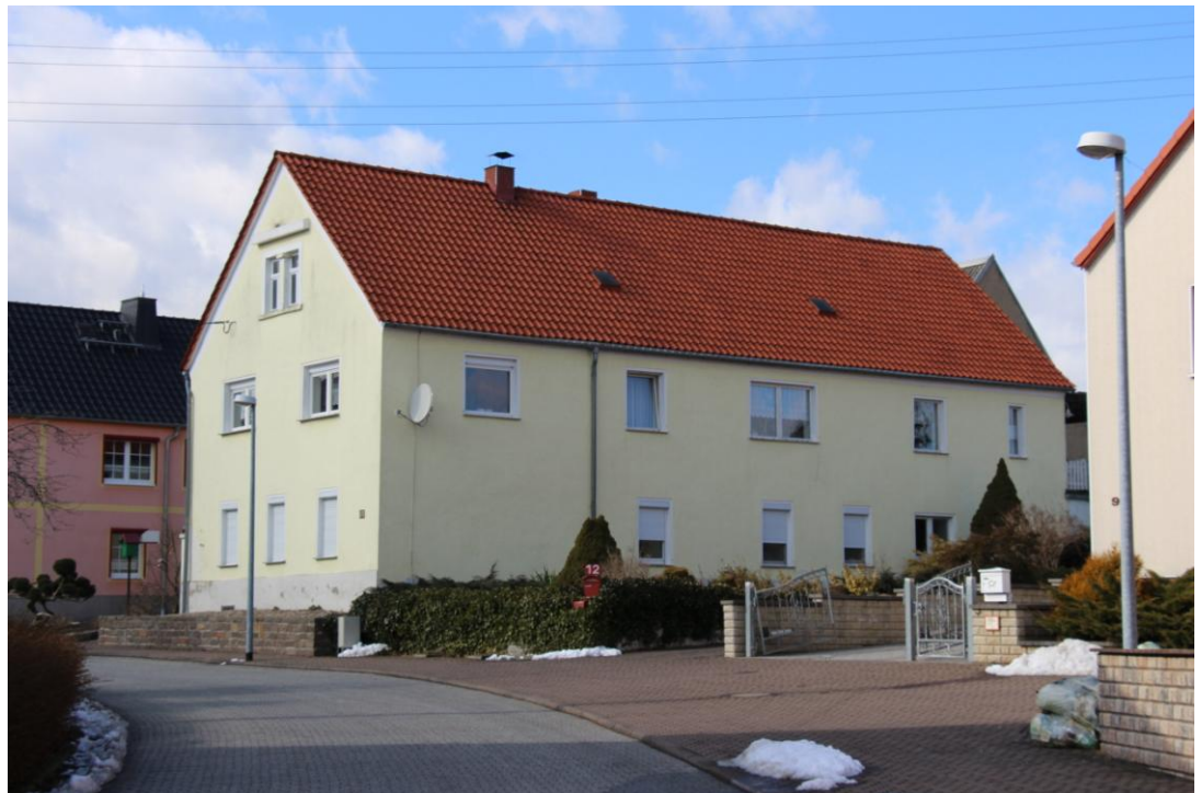
Foto 10: Blick in Richtung Nordwesten auf das Wohngebäude IO 4 „Dahlener Straße 12“ . Der hintere Giebel (Nordfassade) zeigt in Richtung des Plangebietes, vgl. Foto 9.
