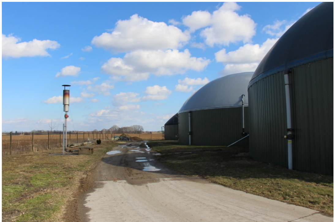
Foto 4: Blick entlang der Nordseite der Behälter der vorhandenen Biogas- und BHKW-Anlage in Richtung Osten.
