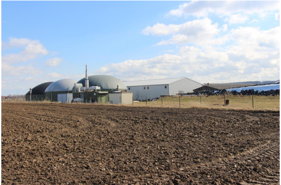
Foto 2: Blick in Richtung Südosten auf die vorhandene Biogas- und BHKW-Anlage der Agrargut Malkwitz KG, die am nördlichen Rand des derzeit bestehenden Anlagen-geländes errichtet wurde.
