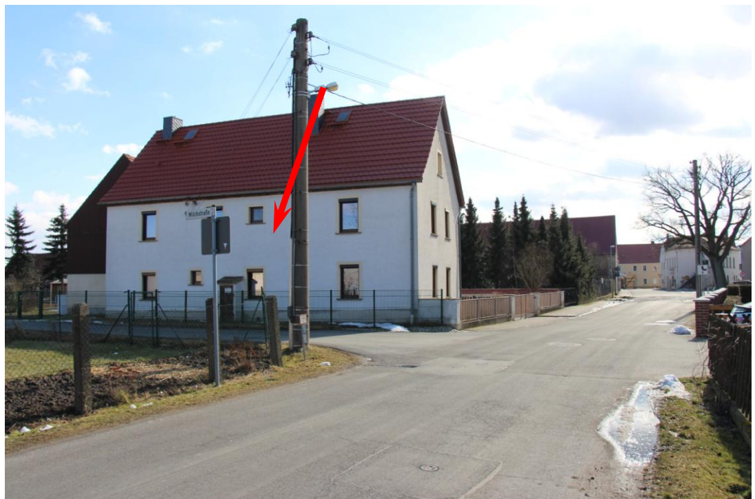
Foto 8: Blick in Richtung Süden auf das Wohngebäude IO 3 „Feldstraße 2“ (Nordfassade).
