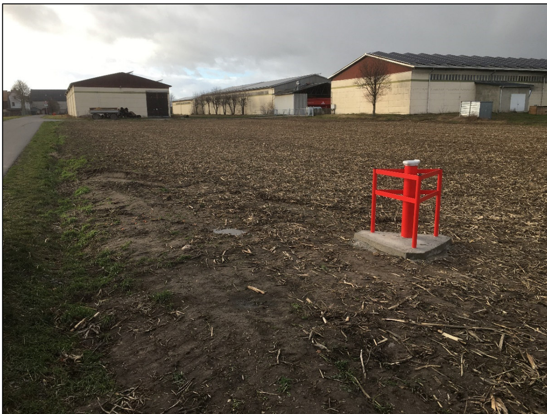
Abbildung 3 Obertägiger Ausbau GWM 3/2022 (östlicher Abstrom)
