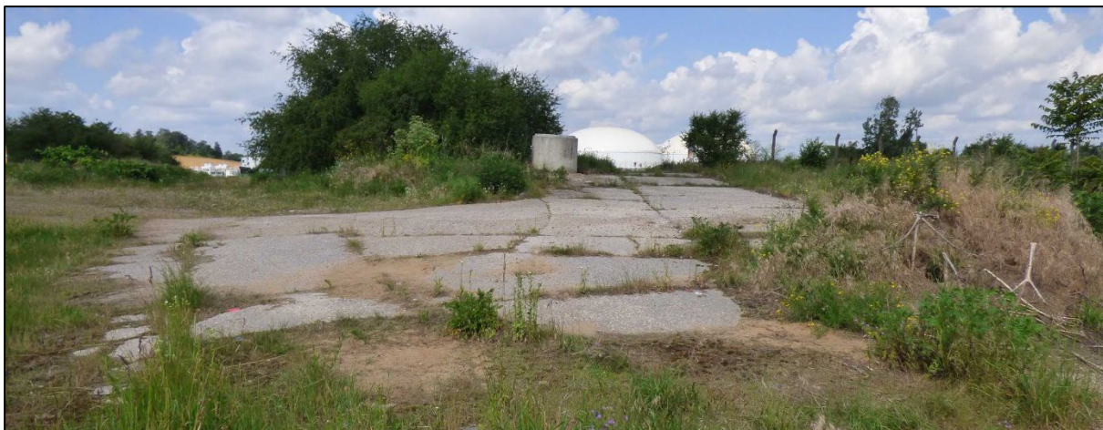
Abb. 9 Weg zur Rampe im östlichen Plangebiet
