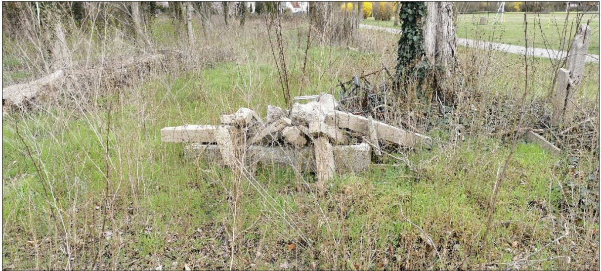
Abb. 15: Betonsteinhaufen im südlichen Plangebiet
