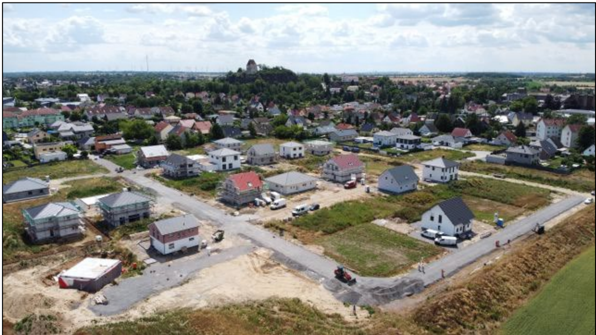
Abb. 11: Zustand des Plangebietes mit vorangeschrittenen Erschließungsarbeiten (BGS Bauherren Grundstücksservice GmbH, 27.06.2023)
