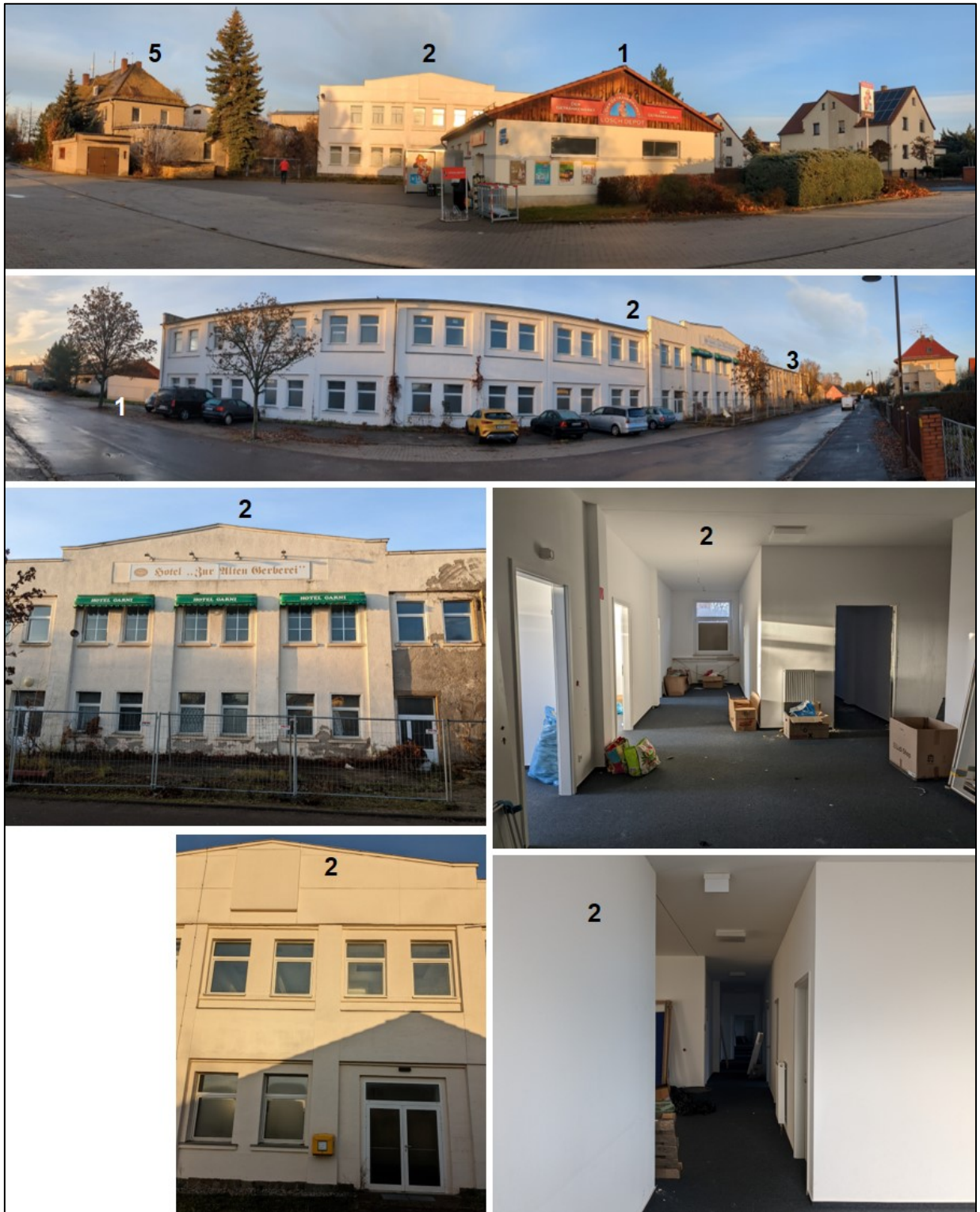
Abb. 8 Aufnahmen der Gebäude Nr. 1 (Getränkemarkt) und 2 (ehem. Bürogebäude und Hotel)
