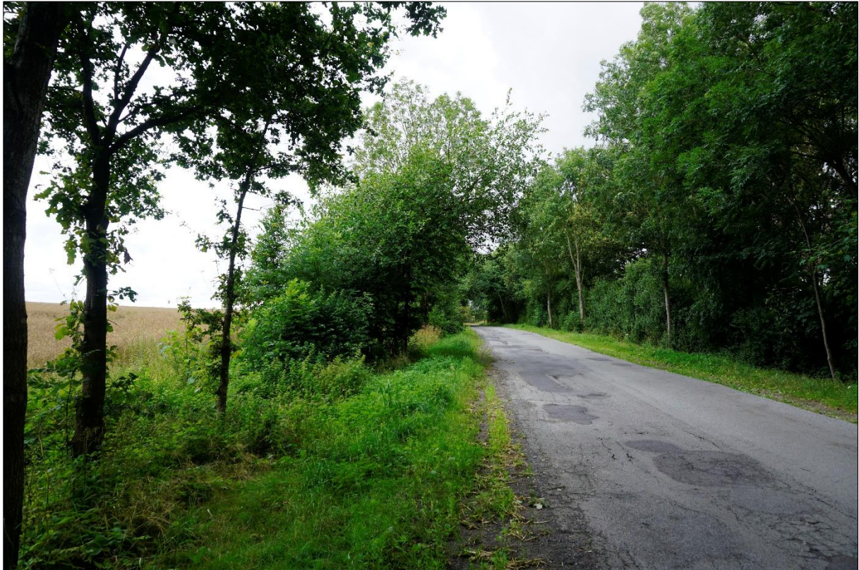
Abb. 38 Straße mit Asphaltdecke und begleitender Vegetation
