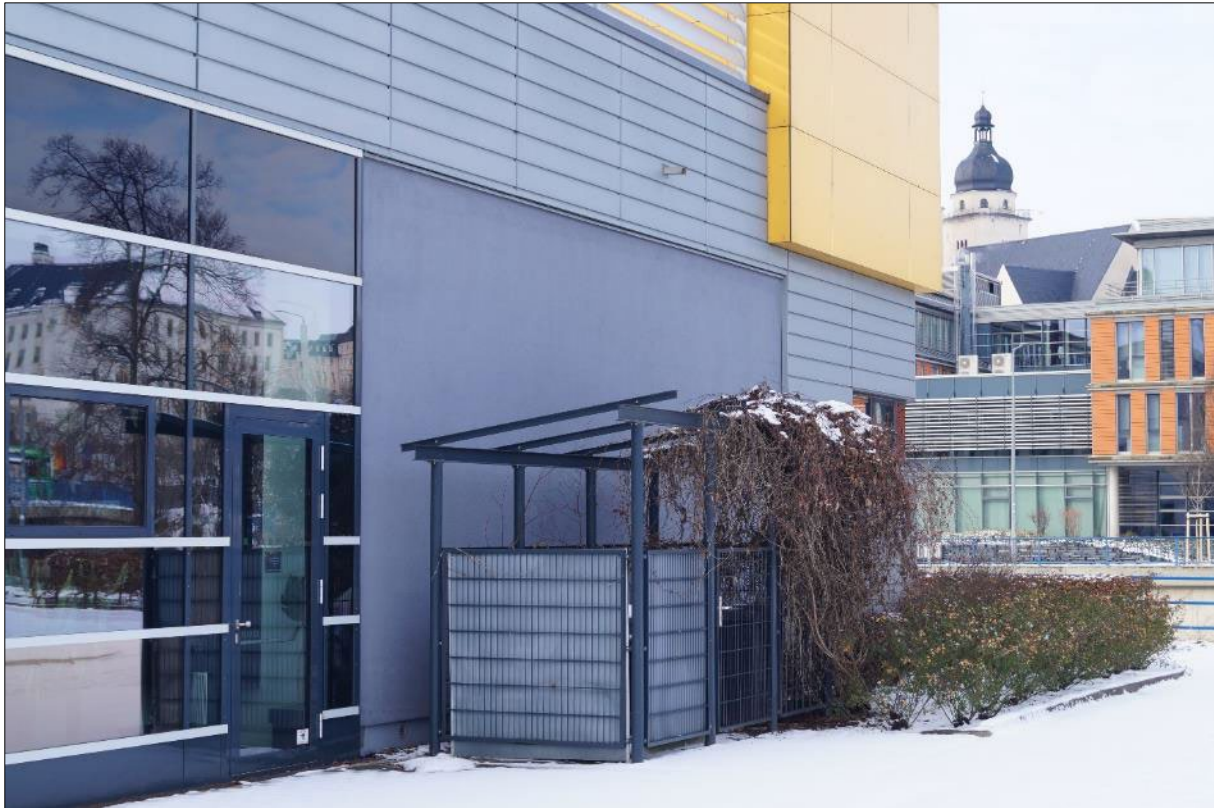
Abb. 14: das Stadtbad umgebender Grünstreifen, hier: nördlich, 01/2021
