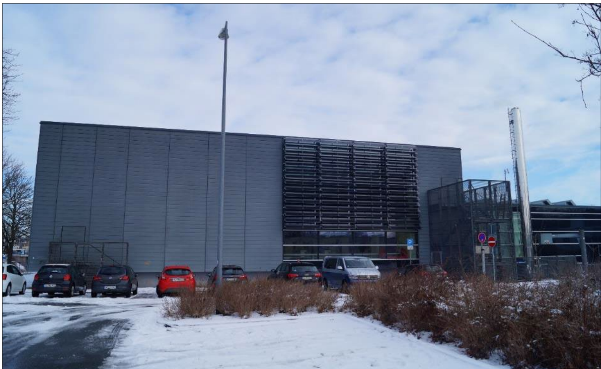
Abb. 6: Parkplatz des Stadtbades, 01/2021
