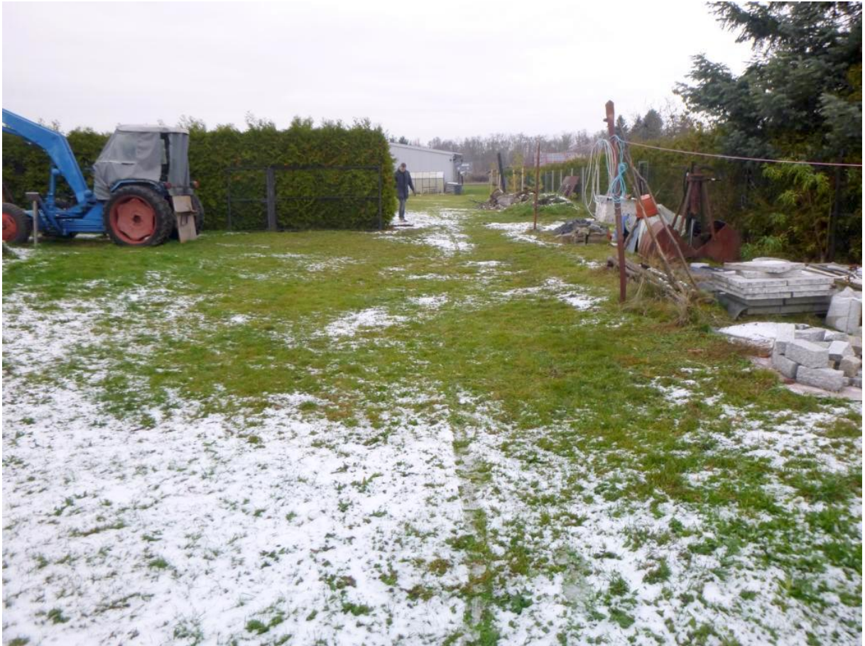
Bild 3: Blick über die Baufläche nach Norden.
