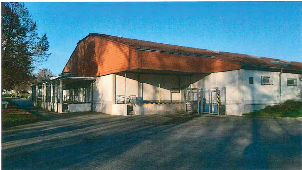
Abbildung: Anlieferbereich und Standort Haustechnik Marktkombination REWE/PENNY/ROSSMANN im Bestand
