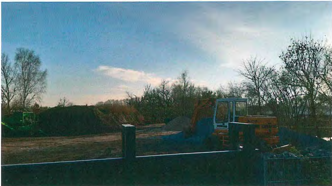
Abbildung: Gartenbaubetrieb am Waldhofsweg im Bestand (gewerbliche Vorlast)
